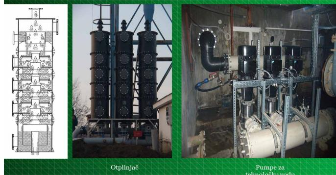
Materijal od kojeg je izrađen reaktorski spremnik je otporan na koroziju, zbog velike količine hlora u vodi. Pritisak u spremnicima reguliše ventil za prigušivanje a tok rada osiguravaju pumpe za regulaciju pritiska. Nakon reaktorskog spremnika THM i KOI filteri gravitacijski izvode filtriranje.
